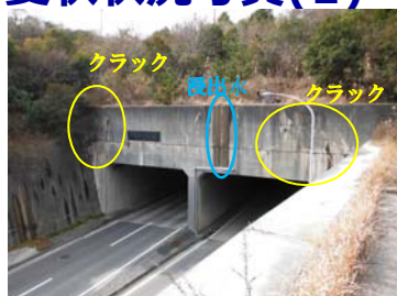
坑口全景（クラック、浸出水状況）
