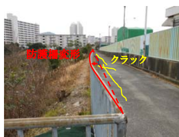
法面上部舗装ひび割れ、防護柵変形
