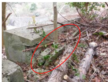
パラペット端部排水溝の破損
