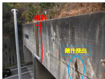
パラペットクラック、浸出水、道路側へ傾斜
