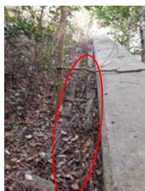
パラペット背面排水溝の破損
