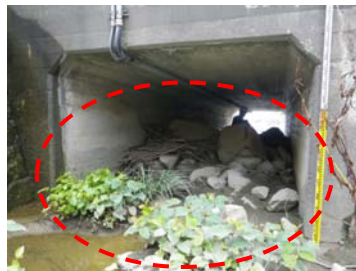
横断排水工が土砂で閉塞しかけている
