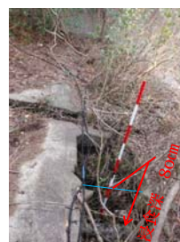
のり枠工空洞化
