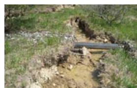
変状箇所のクラック (雨水がたまっている)
